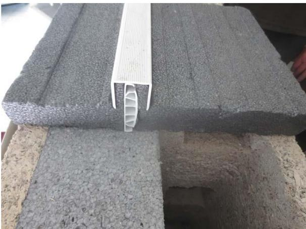
Das für den Holzmantelstein gefertigte Anschlusselement ist gedämmte und thermisch getrennt. Das Fensterbankanschlusselement ist vorgerichtet für alle handelsüblichen Fensterbänke, innen und außen.
